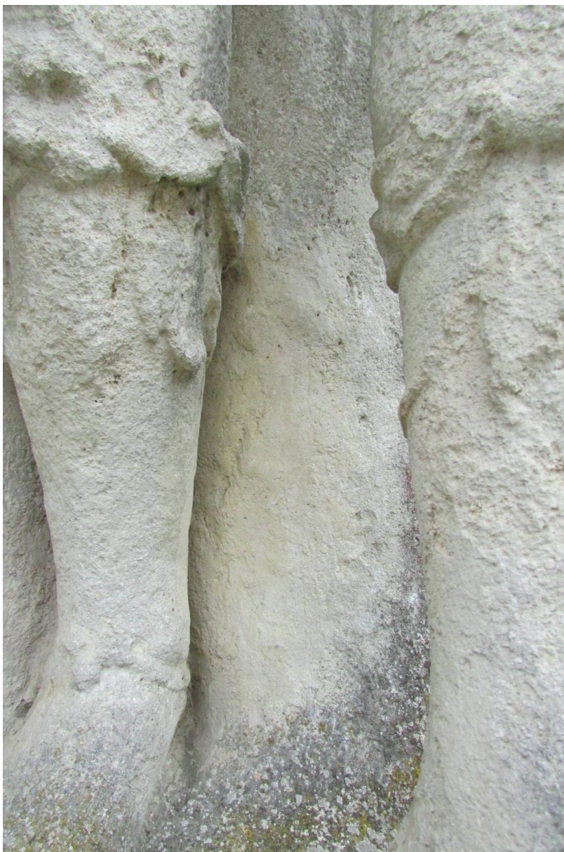
Detail degradace kamenného materiálu
