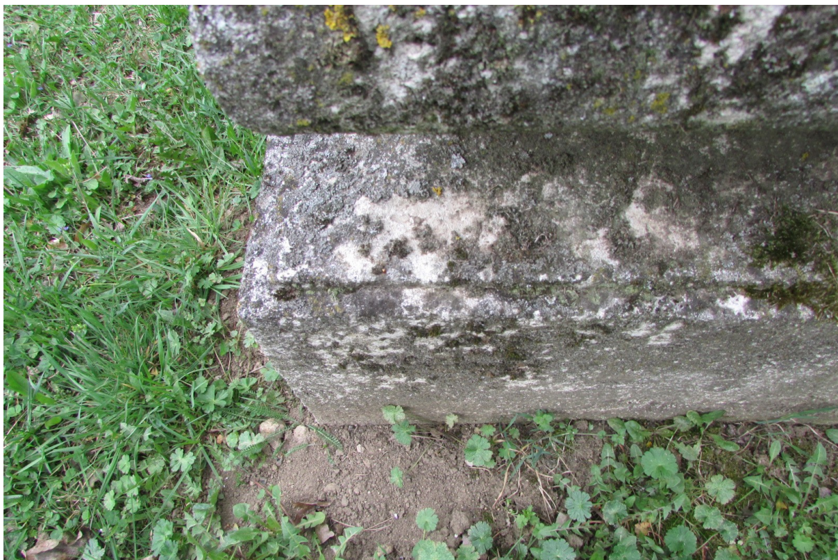
Podstavec, detail biologického napadení
